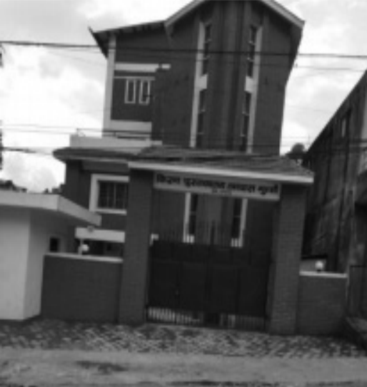
किरण पुस्तकालयको नवनिर्मित भवनको पूवी मोहडा
